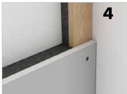
4. Første stolpe placeres tæt til den tilstødende væg og fastskrues. Elementets isoleringsmateriale tilskæres.
